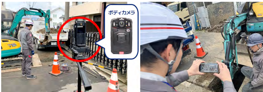
工事現場ではボディカメラでの定点撮影と、スマホでのポイント撮影を使い分ける
